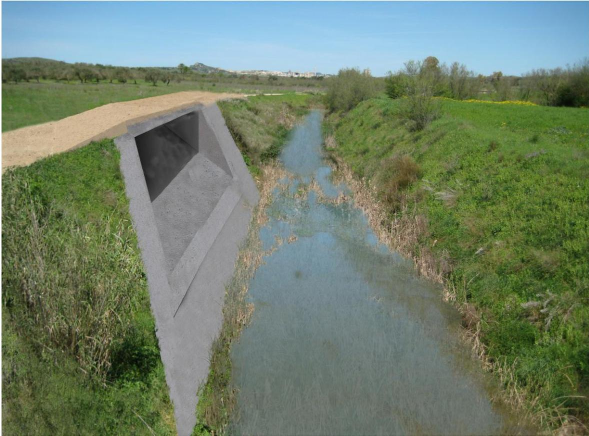
Fotosimulazione dell'opera di immissione a becco di flauto sul Rio Rettore
